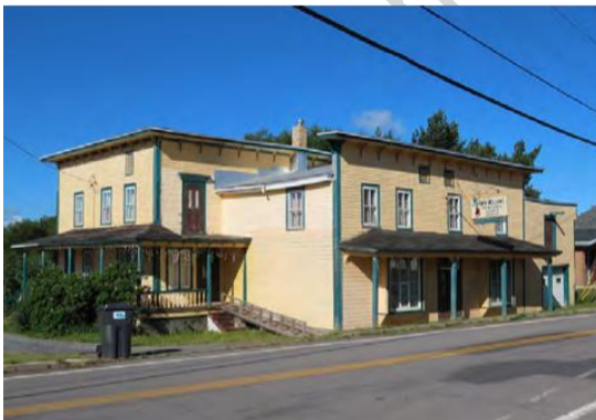
Ancien magasin général Lavoie, présentant une excellente authenticité et une valeur patrimoniale supérieure. 17, rue Lavoie
