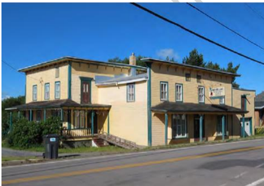
Ancien magasin général Lavoie, présentant une excellente authenticité et une valeur patrimoniale supérieure. 17, rue Lavoie
